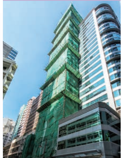
富薈上環II酒店 — 上蓋建築工程大致完成
