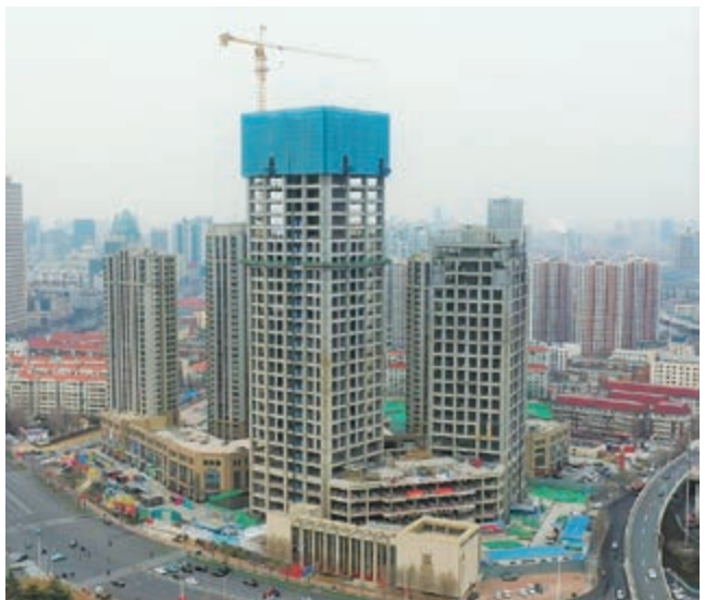
寫字樓大樓及商業平台 — 上蓋建築工程現正進行中
