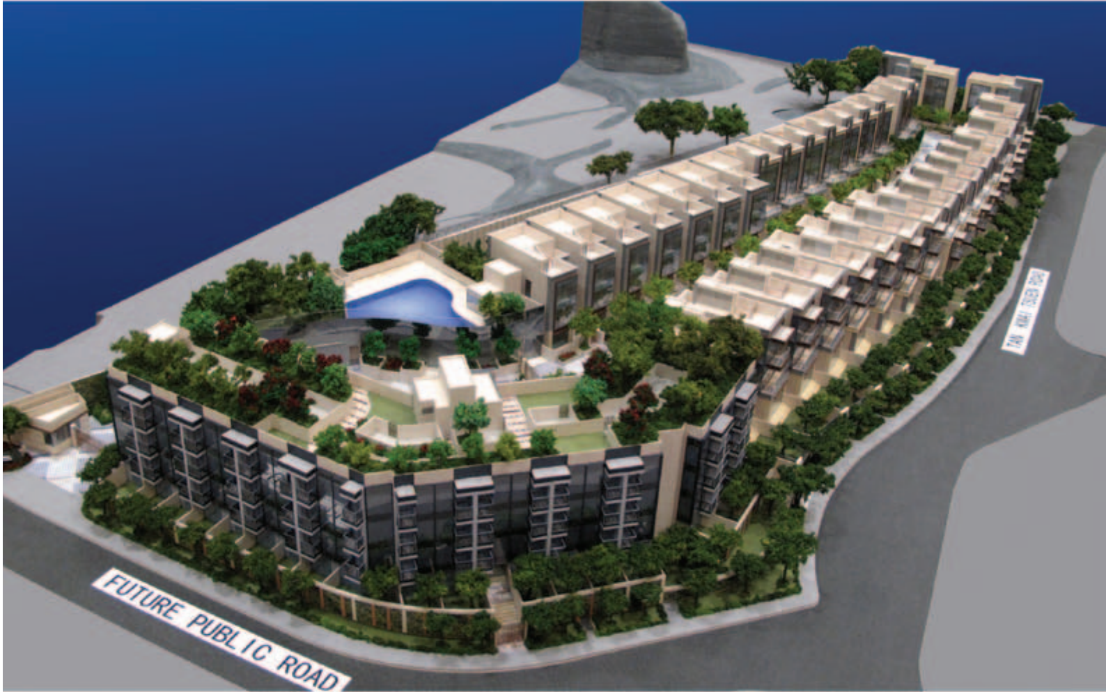
■ 位於新界元朗丹桂村路分界區 124 號地段第 4309 號之住宅發展項目—接近竣工
