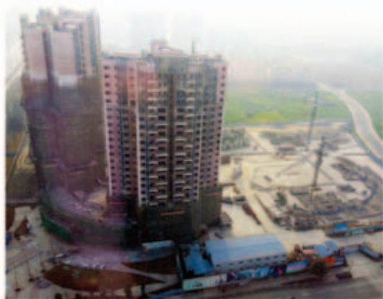
■ 綜合發展項目第一階段之三幢住宅大樓—上蓋工程進行中
