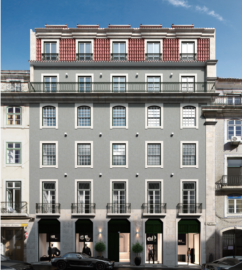
葡萄牙里斯本Rua Dos Fanqueiros 156, Fabrik(*) — 復修翻新工程已完成
